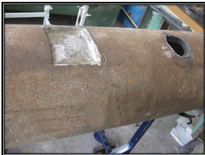
سطح لوله قبل از سنگ زنی
