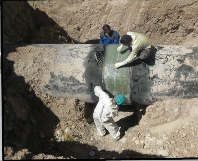
تعمیر خط انتقال گاز سراسری لوله ۵۶ اینچ منطقه چهار محال (آذر ۹۵)
