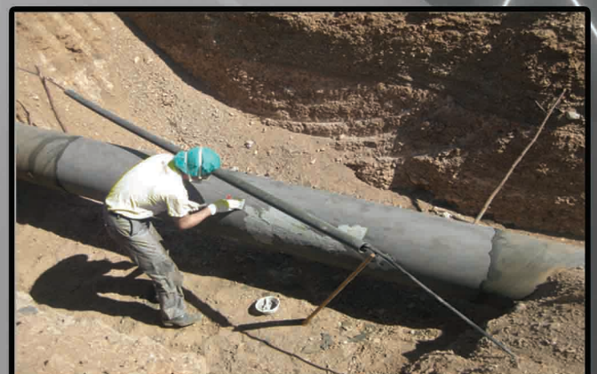
پوشش کامپوزیت پیشرفته بر روی لوله ۱۸ اینچ صنایع فولاد مبارکه (تیر ۹۵)
