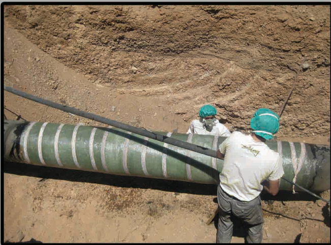
تعمیر خط انتقال سراسری لوله ۲۰ اینچ منطقه یزد (خرداد ۹۴)
