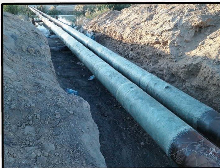
تعمیر خط انتقال ۱۲ اینچ نفت مناطق نفت خیز جنوب (اروندان) (اردیبهشت ۹۶)
