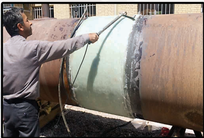
انجام تست هالیدی بر روی لوله ۴۲ اینچ تعمیر شده در منطقه ۲ عملیات انتقال گاز ( خرداد ماه ۱۳۹۳ )
